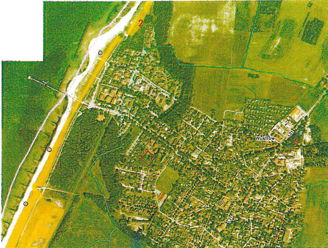
Abbildung 4: Luftbild des von der Planung betroffenen Umfeldes mit Darstellung der geschützten Biotope, rot umrandet=Plangebiet. Quelle: Kartenportal Umwelt M-V 2018.
